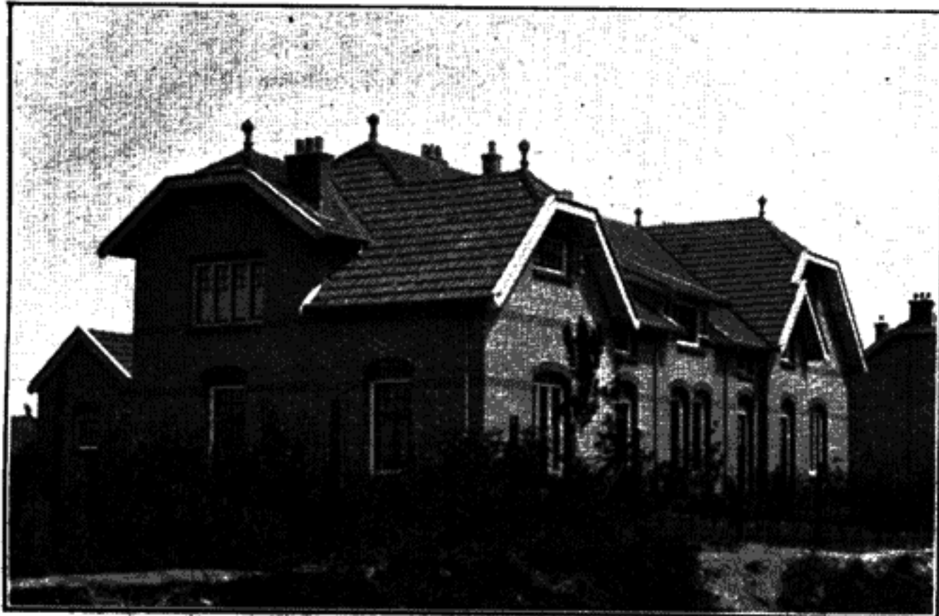
BLOK VAN VIER ARBEIDERSWONINGEN.
