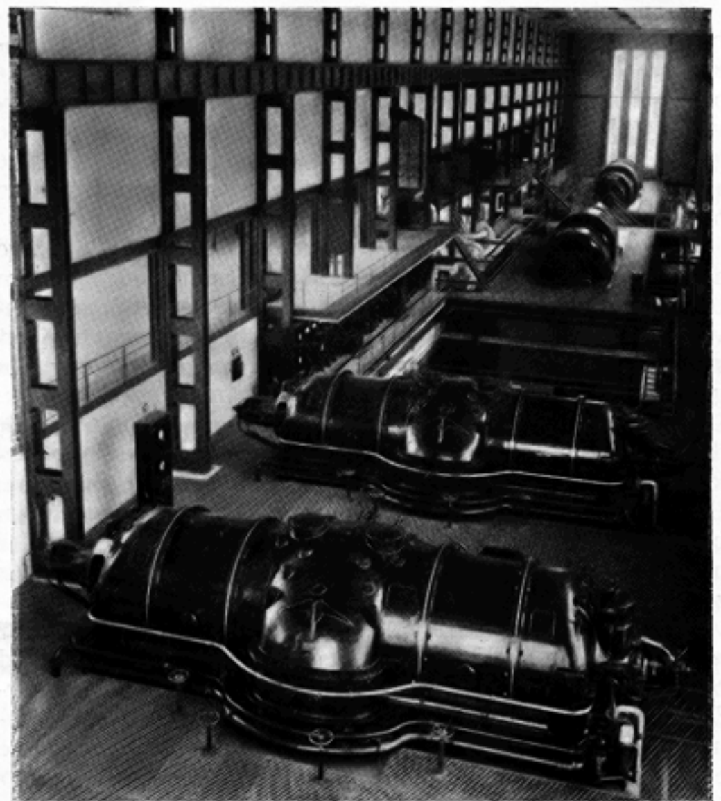
Fig. 1. Overzicht machinezaal, met op de voorgrond de beide nieuwe turbines.
